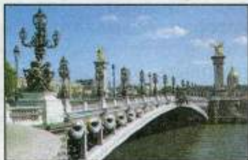
Мост Александра III
