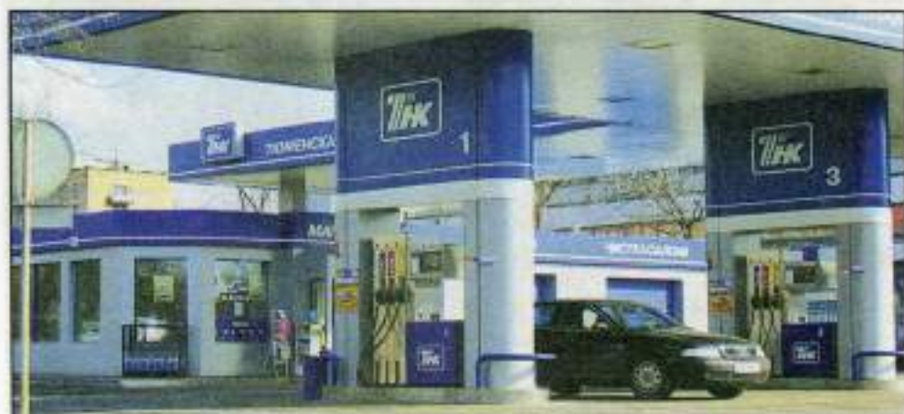
природный газ Автозаправочная станция
